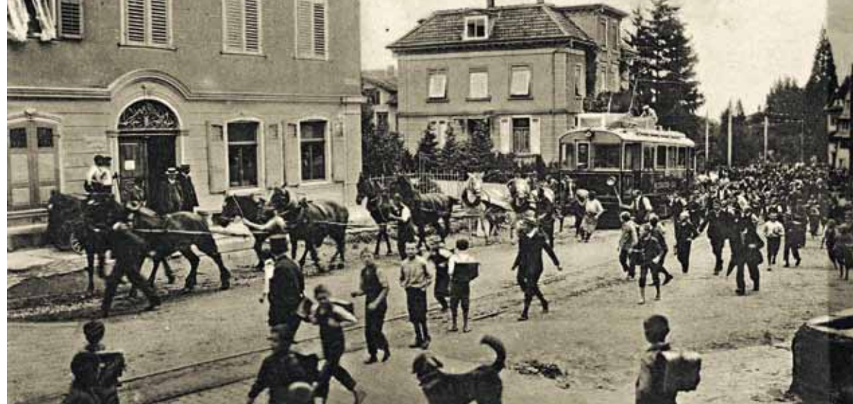
Das Teilstück zwischen dem Altstätter Bahnhof und Altstätten Stadt war nicht rechtzeitig fertiggestellt, so dass Pferdewagen die Fahrzeuge auf der Strasse ziehen mussten.
